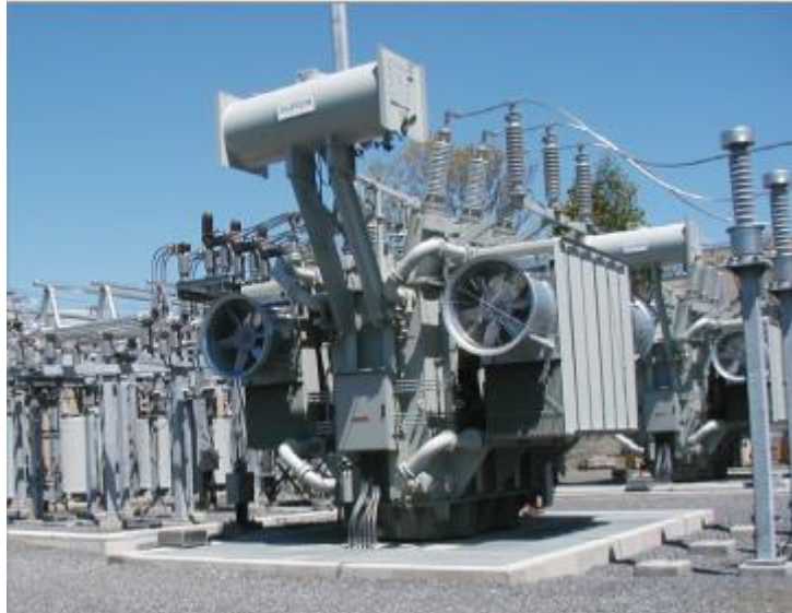
Slika 1.2. Izgled SVC transformatora [49]
