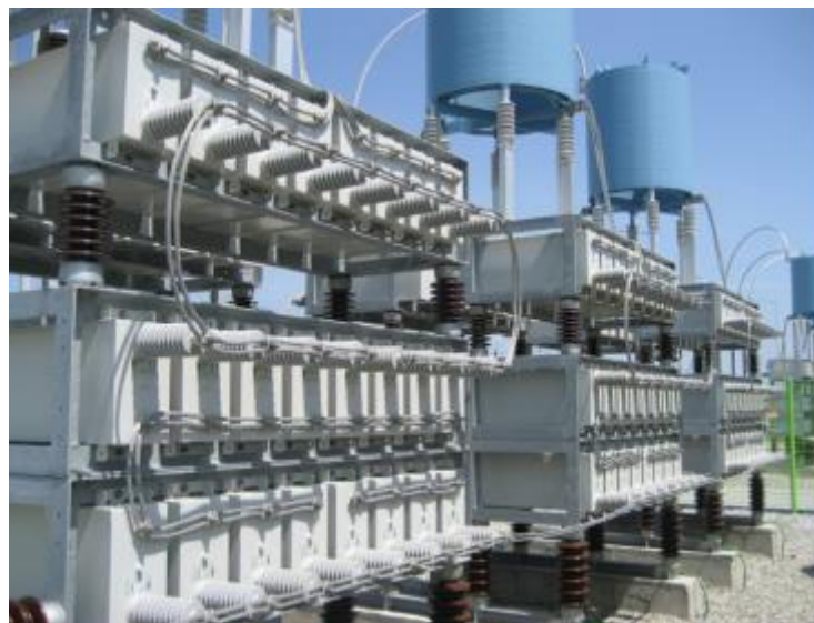
Slika 1.10. Izgled TSC dijela u postrojenju [49]
