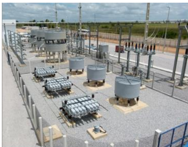
Slika 1.5. Izgled filtra za eliminaciju harmonika [49]
